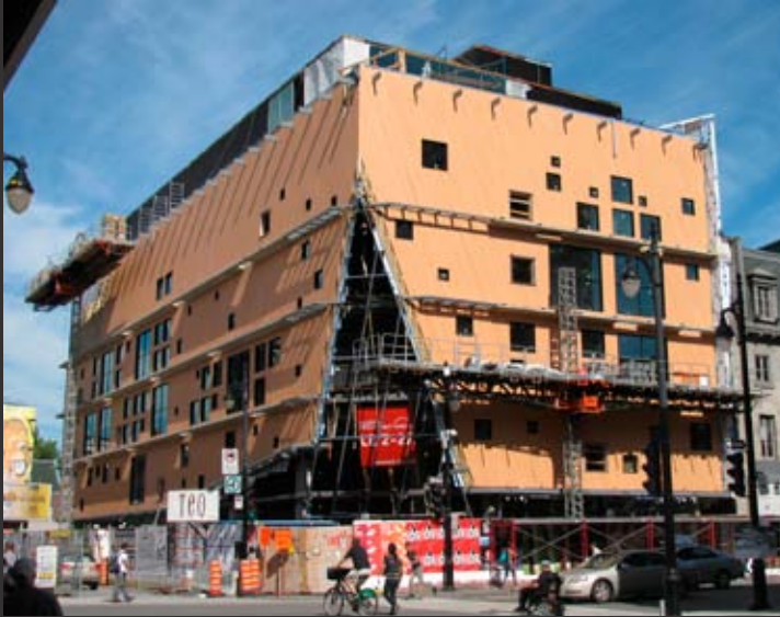
Le 2-22 en construction à l'été 2011.
